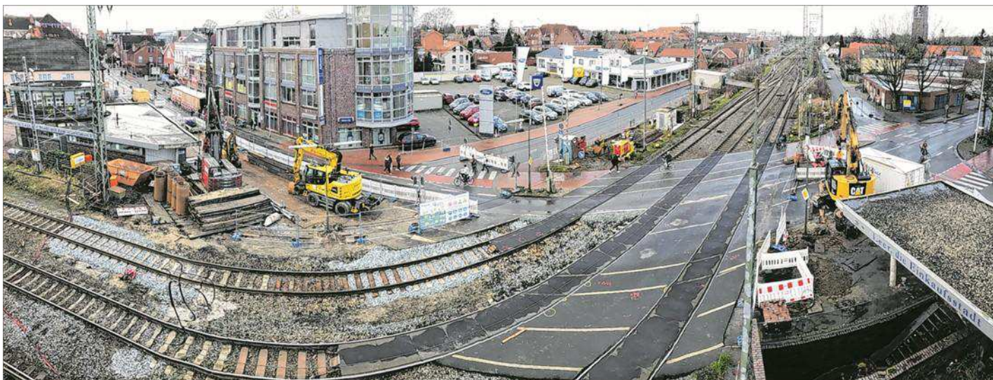
An dieser Stelle werden die Hilfsbrücken eingezogen, über die während der Bauphase die Züge rollen können. Dazu wurde der Asphalt entfernt und die Oberleitung modifiziert. Das Baufeld ist da, wo der Bagger steht. In dem Panoramabild werden die Gleise stark verzerrt abgebildet. BILDER: ORTIGES
